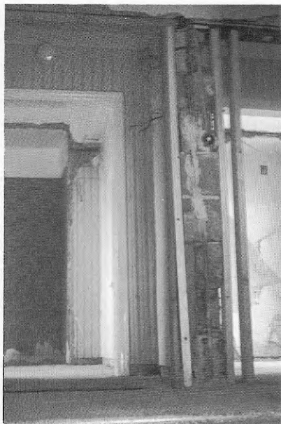
Rivning av väggpartier
