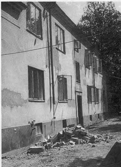
Fasad före renovering
