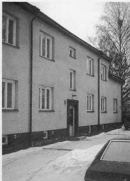
Fasad efter renovering Foto: Kenth Hjelte
