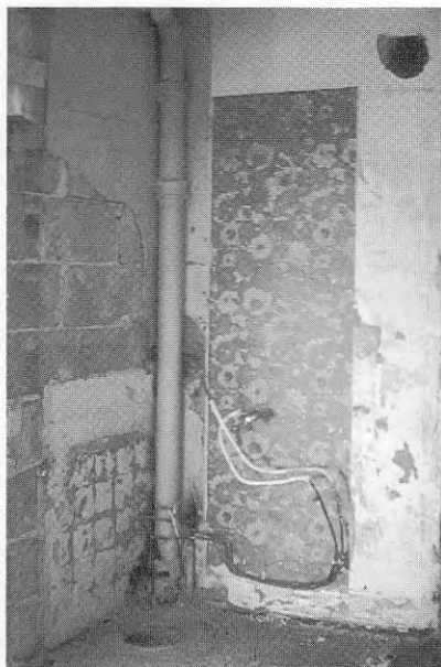
Rivning av duschrum Foto: Kenth Hjelte
