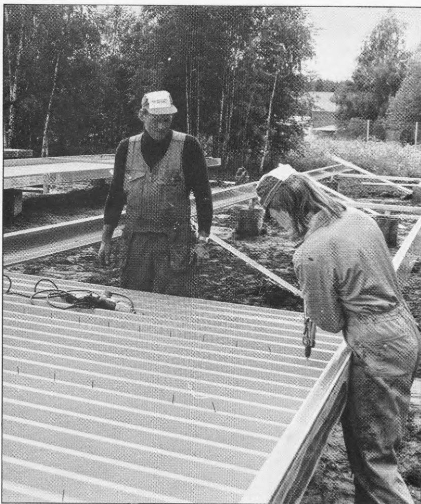
Fig 3.5 Montering av korrugerad plåt vilken senare utgör underlag för isoleringen.
