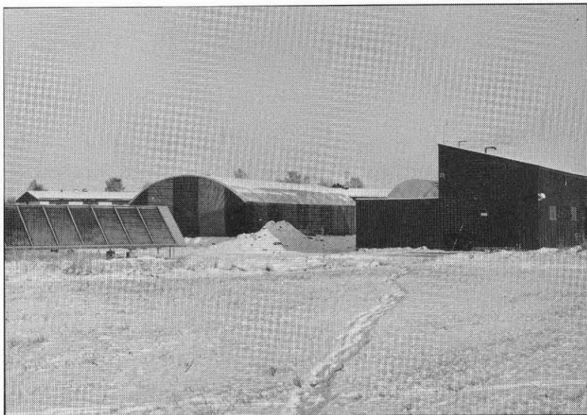
Fig 2.6 Den befintliga värmecentralen (Norr) ses här t h på bilden med den utomhus placerade ackumulatortanken bakom avskärningen. Solfångarna ses t v och tältet i bildens mitt döljer ett annat BFR-projekt, nämligen ett mindre gropvärmelager om ca 250 m 3 .
