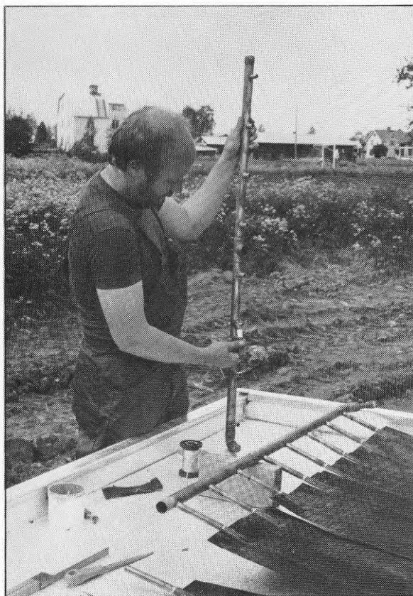
Fig 3.10 Lödning utomhus kan vara en vanskelig metod vid sämre väder än vid arbetet i Malung.
