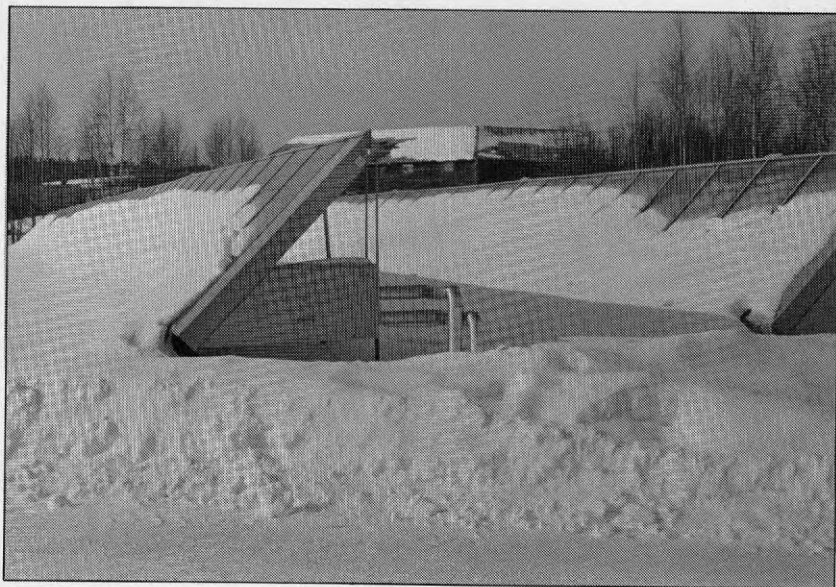
Fig 6.6 Mitt i vintern har snön inte längre plats under solfångarna som här i febr/mars -88. Nederbörden denna vinter var extremt stor men mycket föll som regn och blötsnö varför snödjupet ändå var litet.
