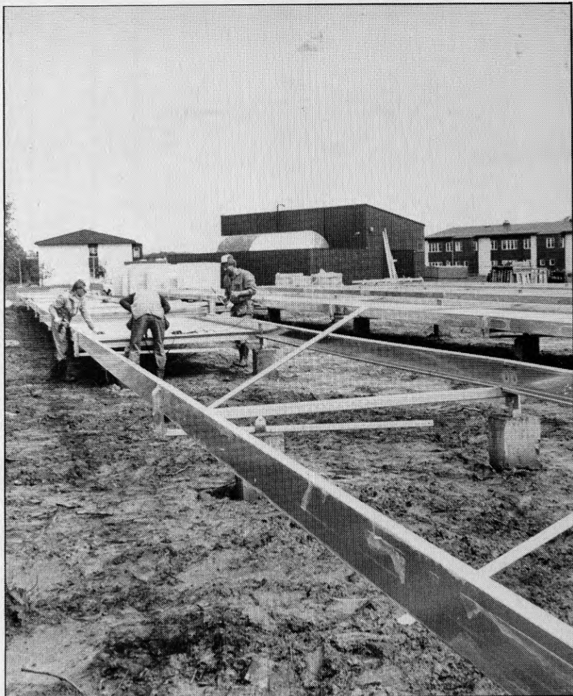
Fig 3.4 Montering av stomme på Storbygärdet i Malung sommaren -87.
