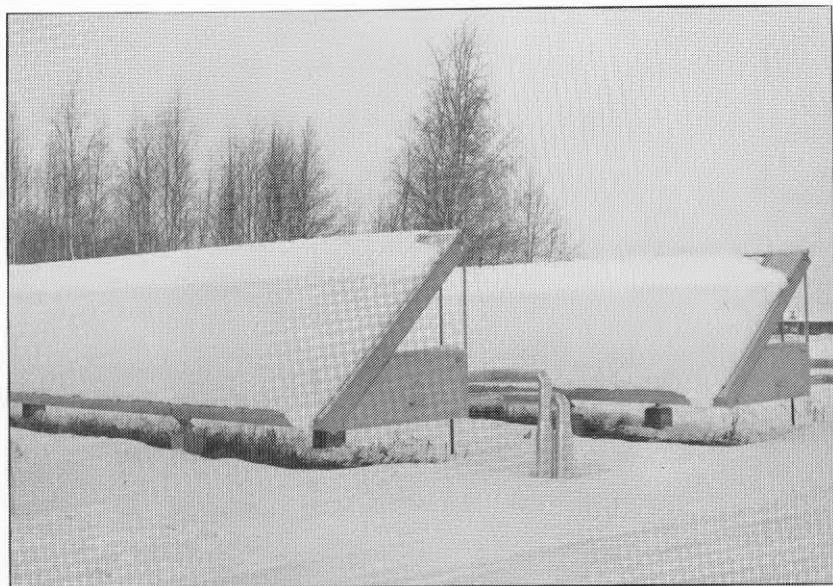
Fig 6.5 Även snön i december rasar av vid minsta töväder så länge det finns plats på marken.
