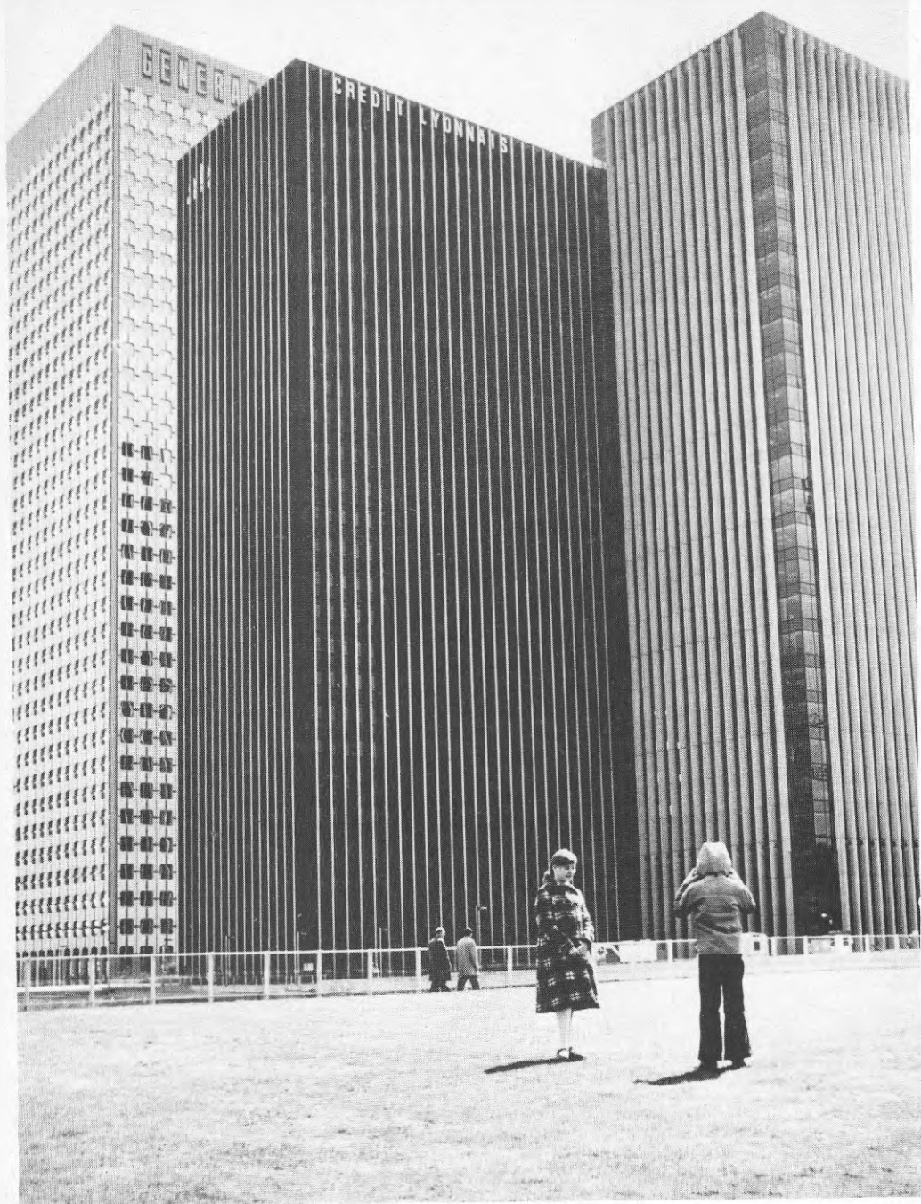
Storföretagens administrationstorn i centrala La Défense
