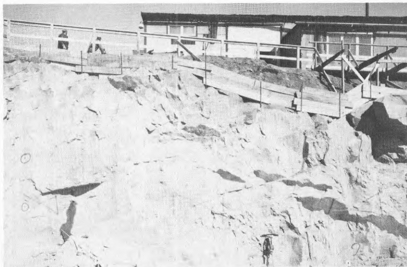
Fig. 5. Schaktvägg vid arbetsplatsen Archimedesvägen, Bromma.
