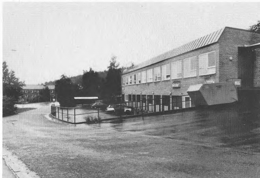
Bild 4.5 Exempel på halvintegrerad verksamhet i friliggande byggnad, Kortedala Glasmästeri, ett företag inom byggnadsverksamhet på Minutgatan i Kortedala
