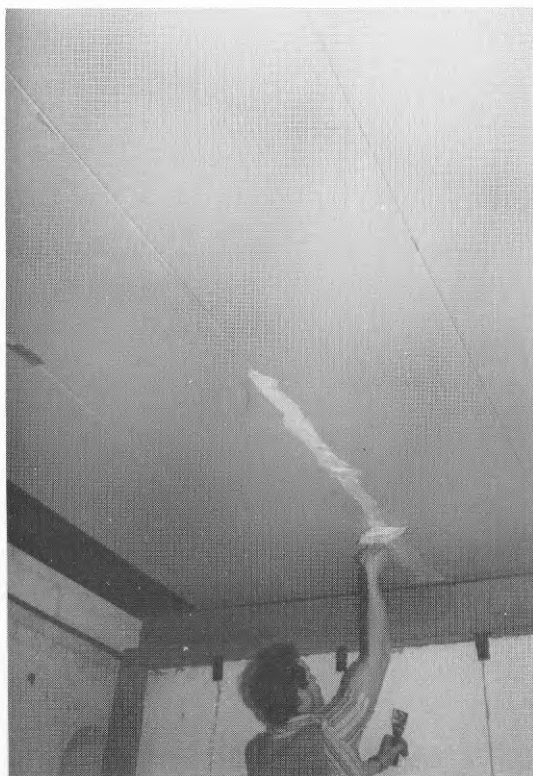
Bild 1.2 Elementen fogades sam- man och spacklades från undersidan.
