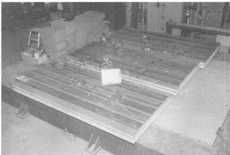
Bild 2.2 Väggelement före monteringen. Alla termoelement på plats.
