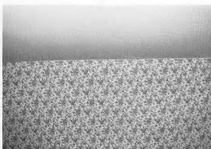
Figur 3.9 Mät punkt 3 Anslutning mellan hanbjälk- lag och snedtak. Övervåning
