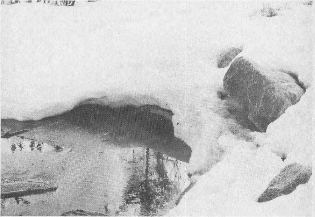
Figur 12. Helt dämnd utloppsledning under snösmältning.
