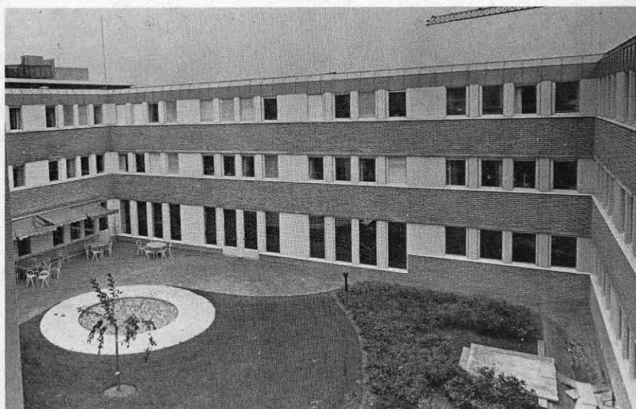
Figur 5.34 En annan av Ö Malmens gårdar sedd från översta våningen. Perspektiv och intressecentrum förskjuts med ändrat höjdläge och himlen blir mindre avskärmad.
