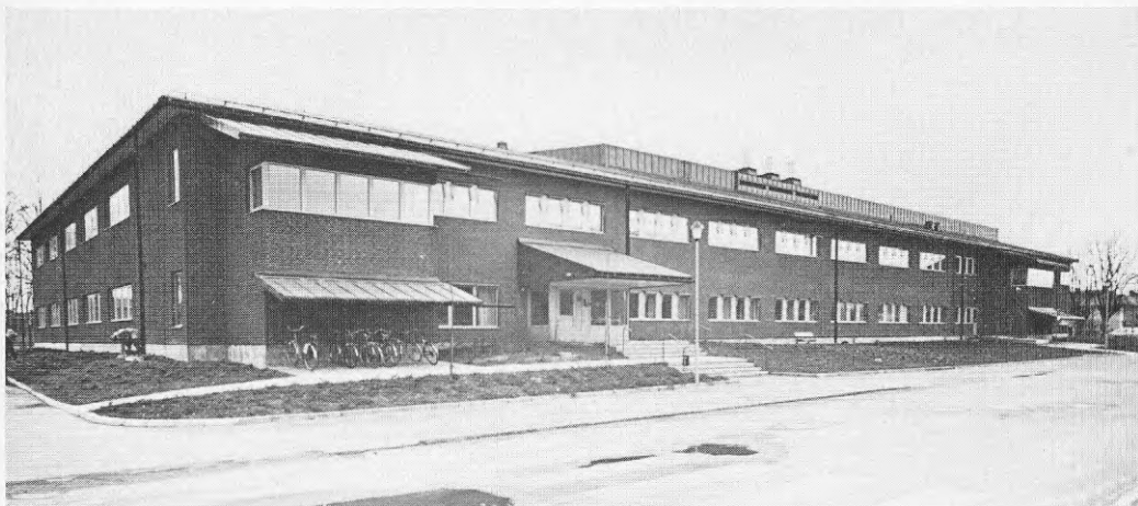
Figur 5.8 Kalmar, Televerkets Datacentral.
