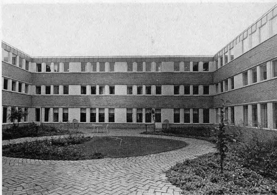
Figur 5.33 En av gårdarna i Ö Malmen sedd från bottenvåningen. Taket har lutats och kanten brutits för att ge en låg taklisthöjd.
