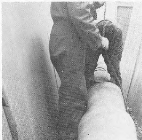
Figur 4.7. Rörläggning, metod 2, lyft med stropp av betongrör \varnothing 300 mm.
