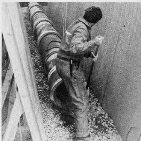
Figur 4.11. Hoptryckning av \varnothing 400 mm, bredd 90 cm. Röret hängande i sling.
