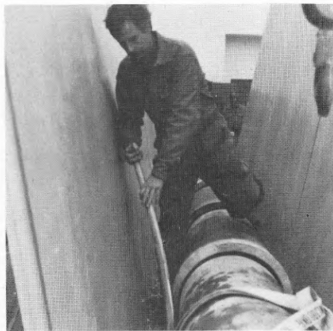
Figur 4.27. Understoppning, b = 80 cm, \varnothing 300 mm betong. Ideligen måste rörläggaren kliva över röret från den ena sidan till den andra. På båda sidor finns det knappt plats att stå på och ännu plats för att utföra ett gott arbete, hur dålig arbetsställning man än intar.
