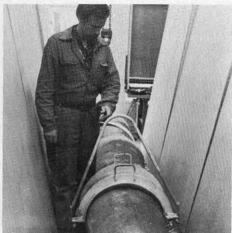
Figur 4.22. Läggnig av \phi = 300 mm i 80 cm sektion. Stora problem att hantera verktyg och hjälpmedel i en grav som knappast medger egen förflyttning.
