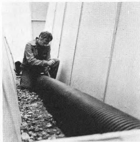
Figur 4.15. Hopkoppling av DSA-rör, ø 200 mm, längd 3 m.
