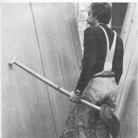
Figur 4.18. Förarbete rörgrav, b = 60 . Denna rörgrav med släntning 5:1 ger inte ens möjlighet att vända en normal skyffel i arbetshöjd.
