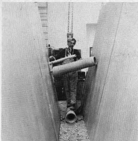
Figur 4.20. Läggnig av \phi = 150 mm, betong i 60 cm sektion. Rörret på lyftgalgen går inte att vända i normal arbetshöjd.
