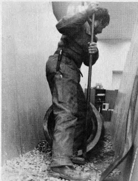
Figur 4.5. Hoptryckning av rör, metod 1, betong- rör \varnothing 300 mm.
