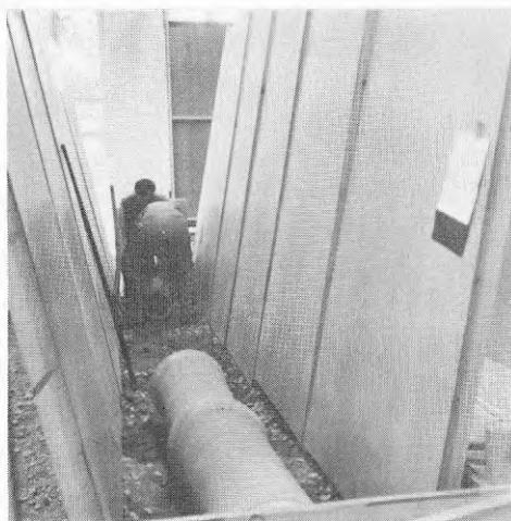
Figur 4.4. Utbärning av rör, metod 1, betongrör ø 225 mm.
