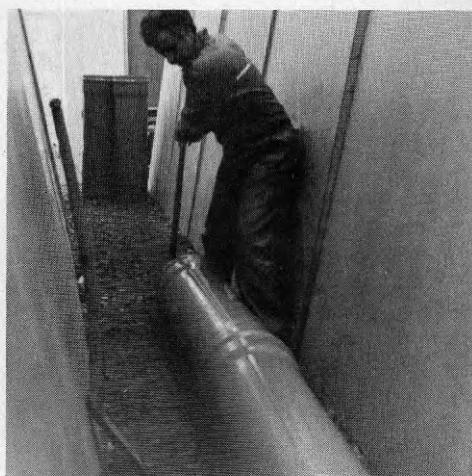
Figur 4.13. Hoptryckning av plaströr LUBONYL-PVC \varnothing 300 mm, längd 1 m.
