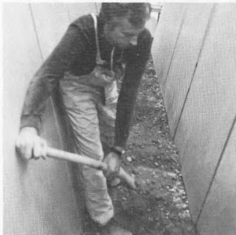
Figur 4.17. Förarbete rörgrav, b = 60 . Graven är så trång att man måste inta en onaturligt rak arbetsställning vid skyffling, vilket ger stora statiska belastningar. Ständigt slår man också emot slänten.
