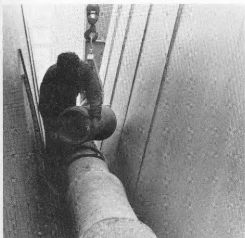
Figur 4.8. Rör \varnothing 300 mm hängande i lyftgalge under påsättning av gummiring.
