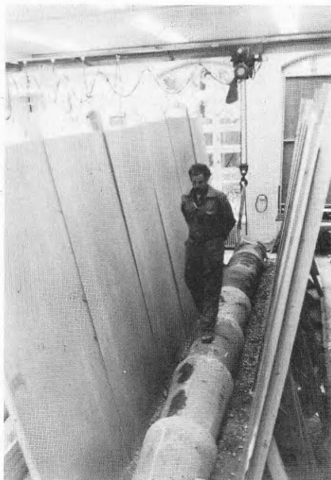
Figur 4.1. Fullskalemodell av ledningsgrav, med betongrörledning och rörläggare.
