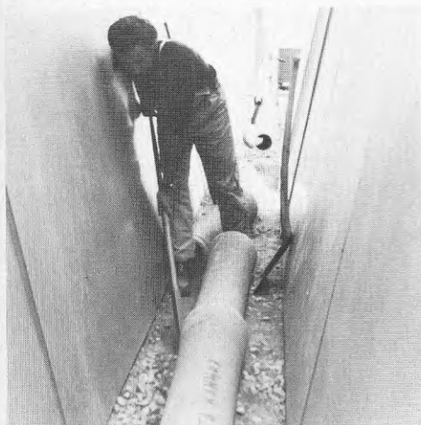
Figur 4.24. Riktningjustering, b = 70 cm och \varnothing 150 mm betong. Svårt att komma intill och få tag med spettet. Man måste luta sig mot slänten för att se vad man gör.
