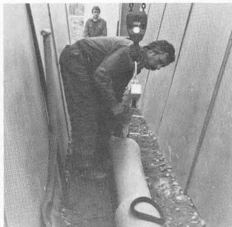
Figur 4.9. Inpassning av rör \varnothing 150 mm lyftgalgen kvar i röret.
