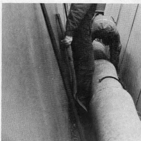
Figur 4.23. Läggnig av \phi = 225 mm i 70 cm sektion. Typsektionerna ökar inte för arbete som kräver två man. Det kan alltså bli mycket trångt och besvärligt att arbeta fast man är två.
