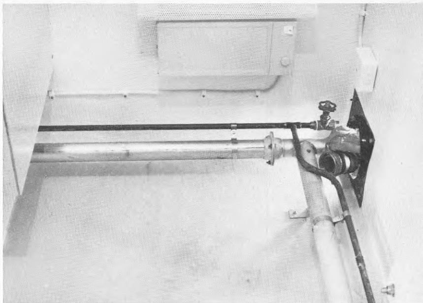
Figur 3.5.7 Fast monterade ledningar
