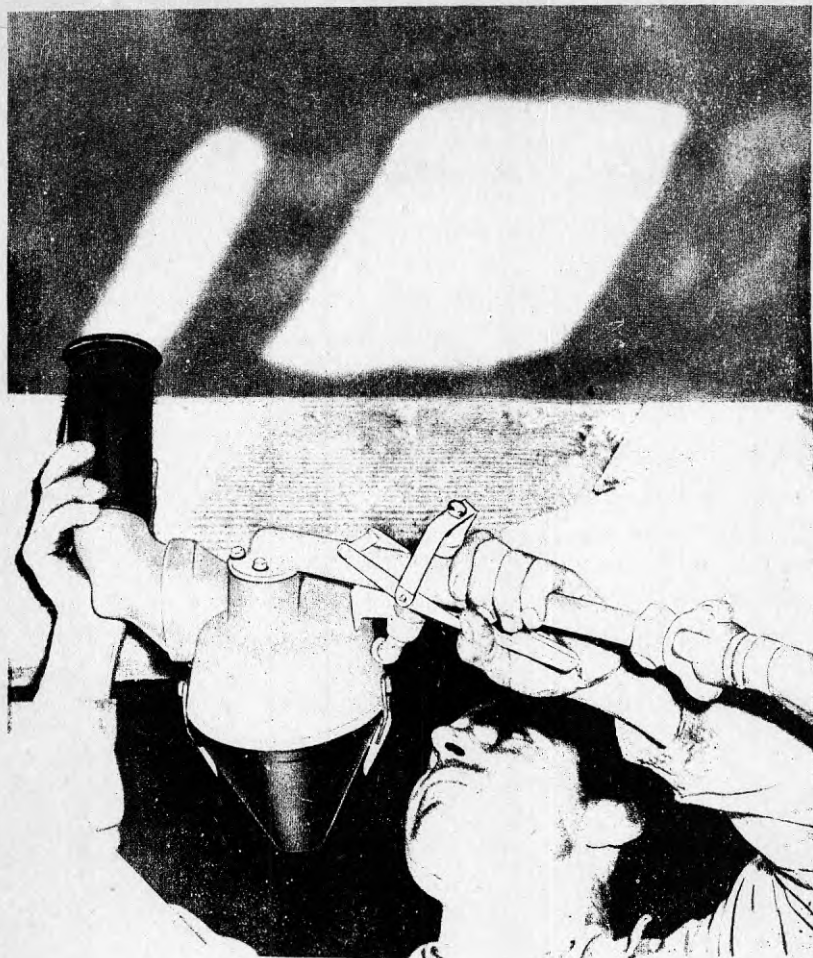
FIG 2. S.k. dammfri blästring med EDUCT-O-MATIC.
