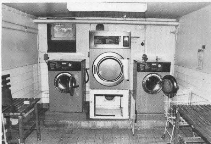
Figur 4.14 Tvättstuga i hus från 1950 (moderniserad)
