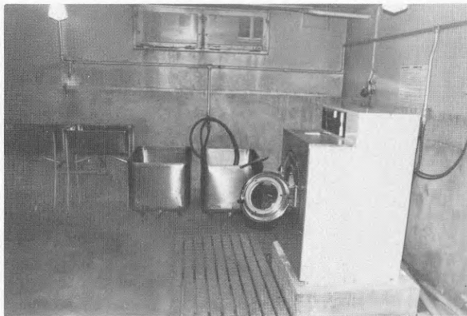
Figur 4.9 Tvättstuga i hus från 1936 (moderniserad)
