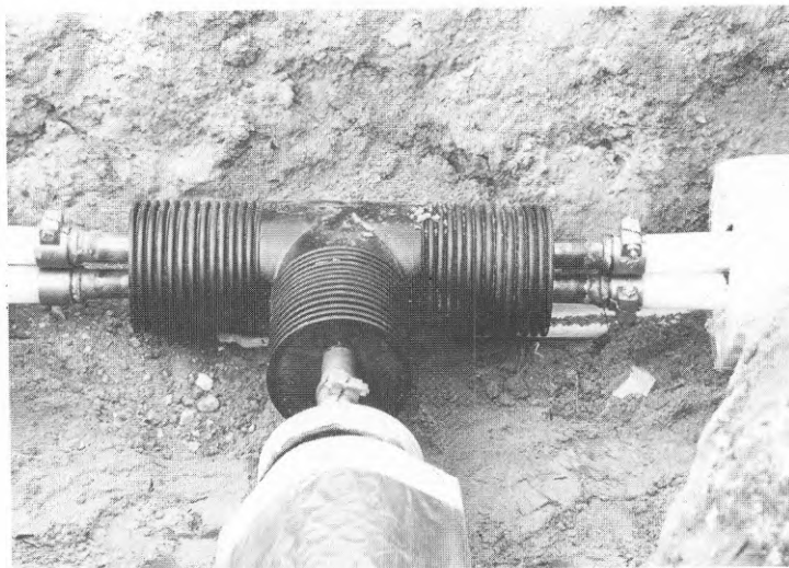
Figur 18 Monterat T-rör.
