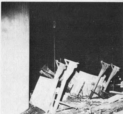
Bild 22. Yttre formdel delas i sex segment och firas ned med hjälp av rep.
