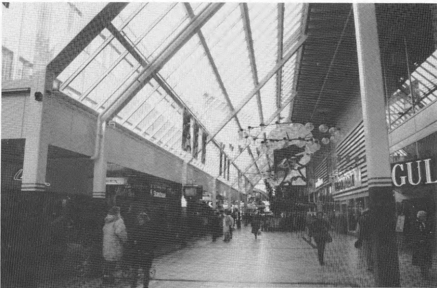
Figur 3.4. Den överglasade Storholmsgatan med 460 m 2 glastak som vetter mot öster. Här framgår bl a att de befintliga utskjutande taken utnyttjades vid inbyggnaden. Miljön är direkt jämförbar med den öppna gågatan ovan.
