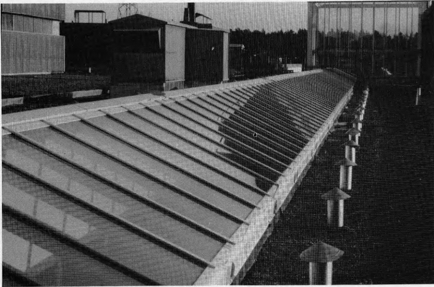
Figur 3.16. Här framgår det mycket långsmala glastaket över Byholmsgången. Alldeles till vänster om glastaket syns ett av ventilationsaggregaten som innehåller till- och frånluftsfläkt och värmeväxlare.
