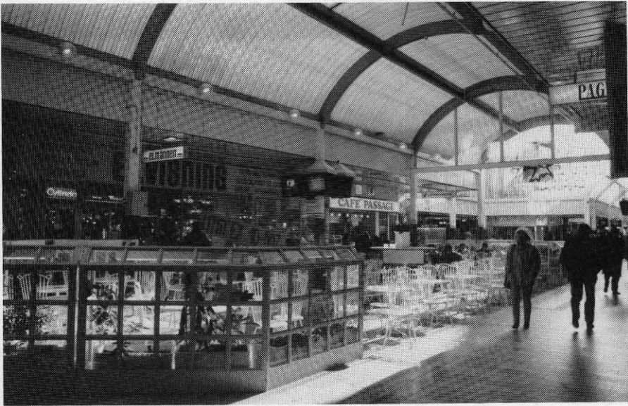
Figur 3.5. Norra och södra delen av Storholmsgatan har tak av 3-skikts opaliserande plastpanel. Detta café är ett exempel på att gågatorna efter överglasningen kan användas för olika aktiviteter, och inte enbart som kommunikationsytor.
