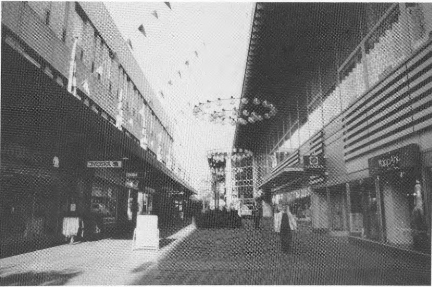
Figur 3.3. Den icke-överglasade Bredholmsgatan (se figur 3.7) ger en god uppfattning om miljön före överglasningen.
