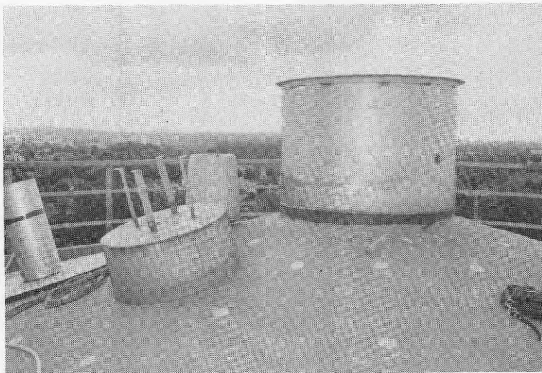
Figur 5.15 Vattenlåset i demonterat skick.
