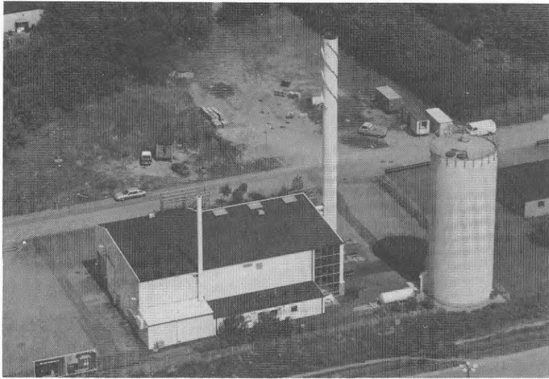
Figur 5.2 Värmecentralen med ackumulatorn.
