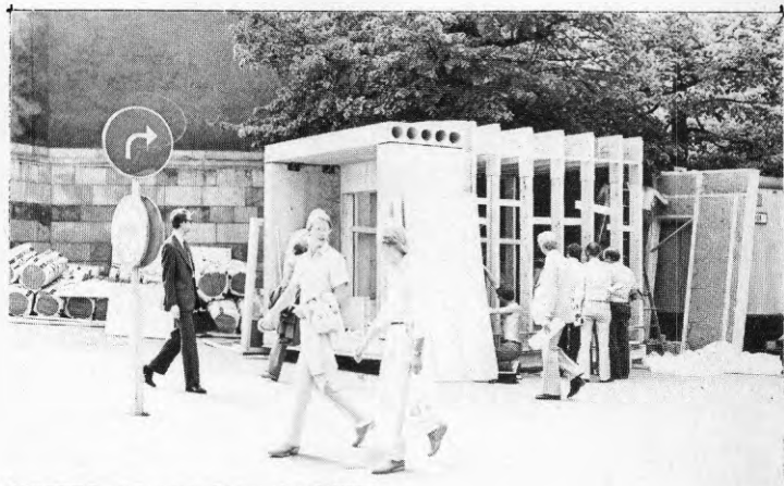
Byggnadens stomme monteras
