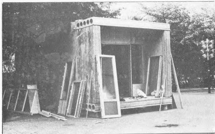
Klart för montering av det främre glaspartiet
