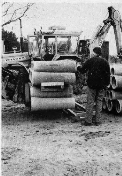
BILD 26 Lossning av rör, alternativ metod
