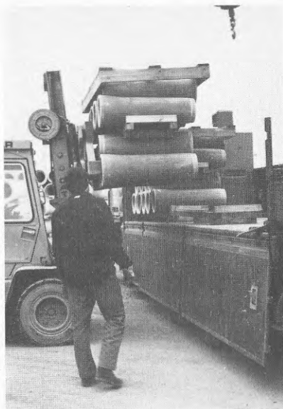
BILD 22 Lastning av rör, alternativ metod
