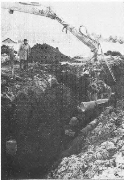
BILD 29 Rörläggning, alternativ metod
