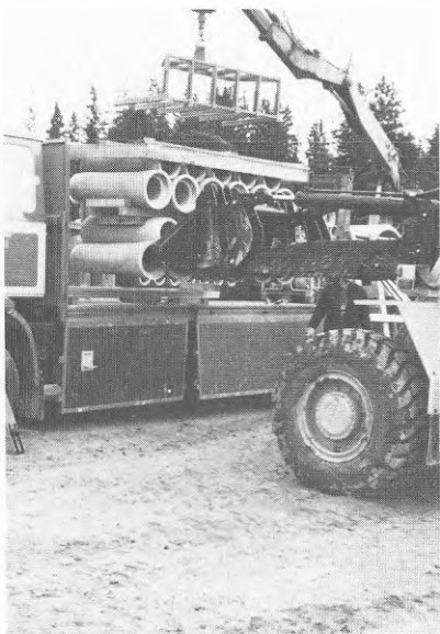
BILD 23 Lossning av rör, alternativ metod
