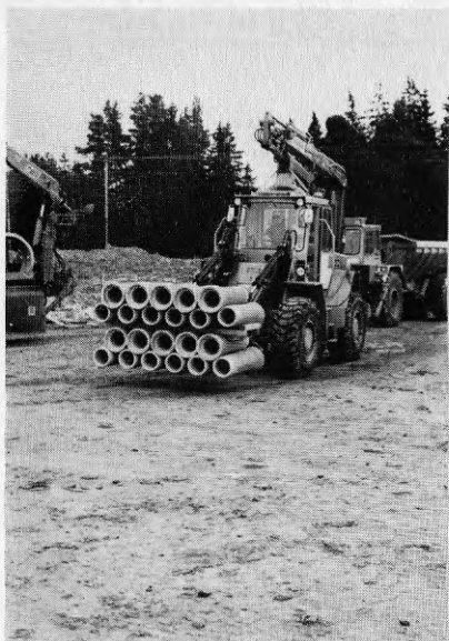
BILD 25 Lossning av rör, alternativ metod
