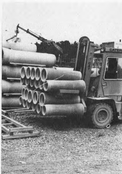
BILD 19 Lastning av rör, alternativ metod
