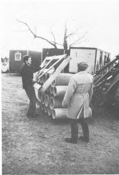
BILD 24 Lasthållaren lyftes av
