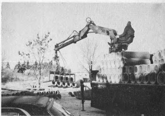
BILD 18 Lossning av rör, konventionell metod
