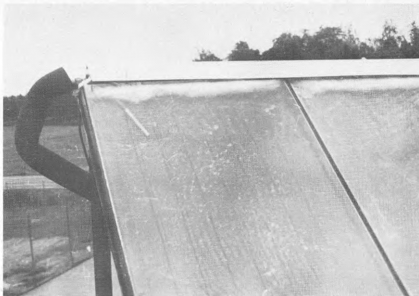
Felaktig placering av temperaturgivare
