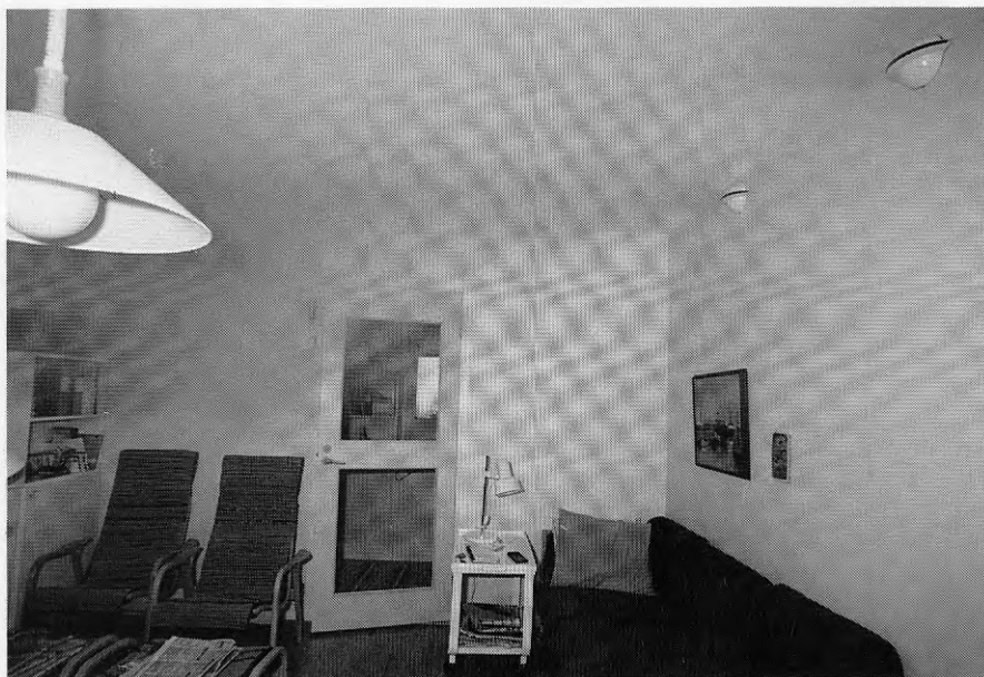
Figur 6.5 Vardagsrum i lägenhet 6E med luftburen värme. Rökpatron har placerats i tilluftskanalen.
