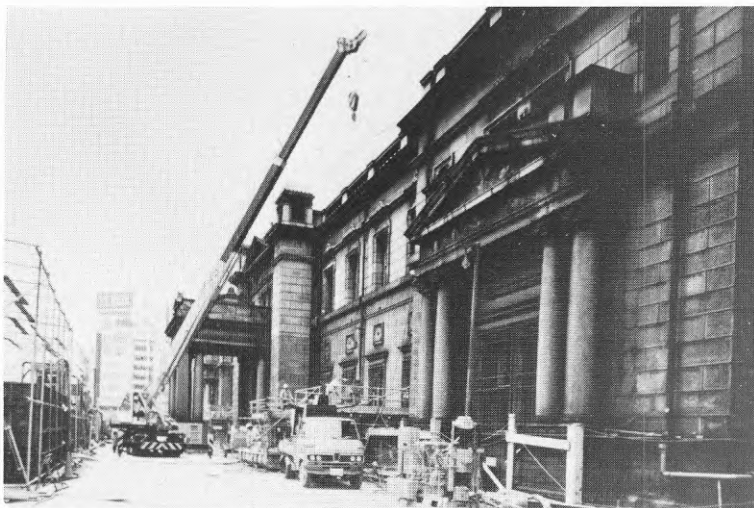
Bild 2. God ordning och framkomlighet karakteriserade arbetsplatsen. I förgrunden en jetpelarmaskin på medar.
