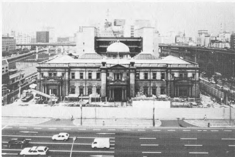
Bild 1. Nippon Bank, Osaka. En gammal byggnad insprängd bland moderna hus och som grundförstärkts med jetpelare.
