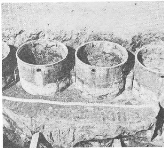
Fig. 9 Bild av framschaktad ving-jet injektering.
