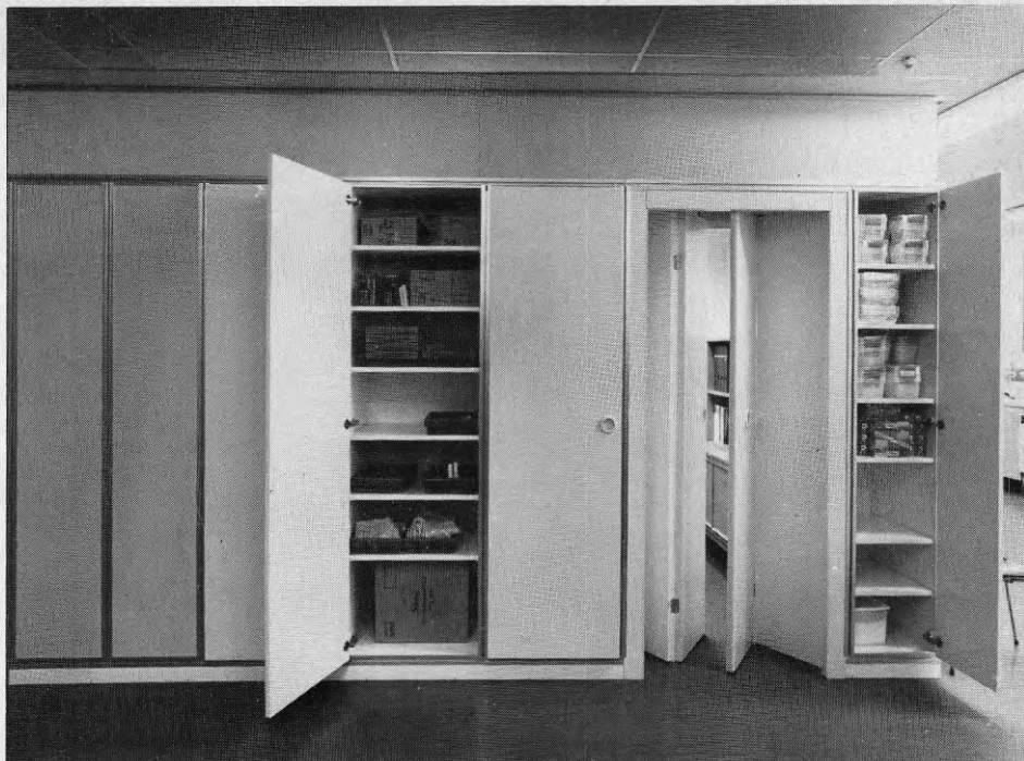
Volymväggen med den dubbla vickdörren, saxdörren.
