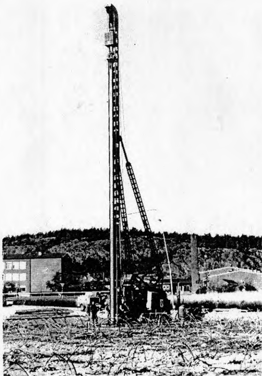
Figur 4.2. Pålkran med specialtillverkat foderrör.
