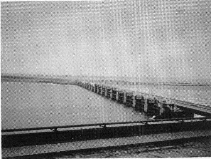
Bild 1. Dambyggnad för skydd mot översvämning (Balfors 1990).
