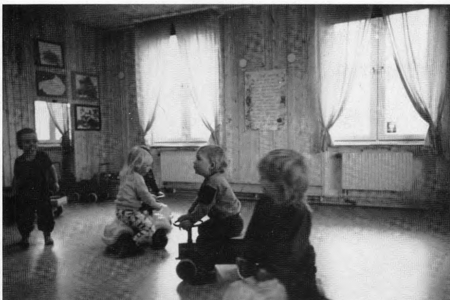
Lekrummens yttervägg har en luftspalt på 10 cm bakom träpanelen. I luftspalten står spirokanaler med 60 cm mellanrum. Frånluften sugts ut i nederkanten av väggen.
