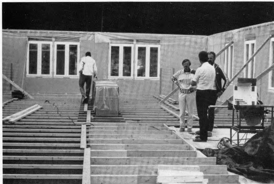
Allt kom snabbt under tak genom att prefabricerade element användes.
