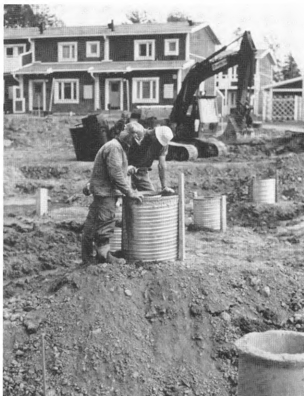
Gjutning av plintar till grunden.
