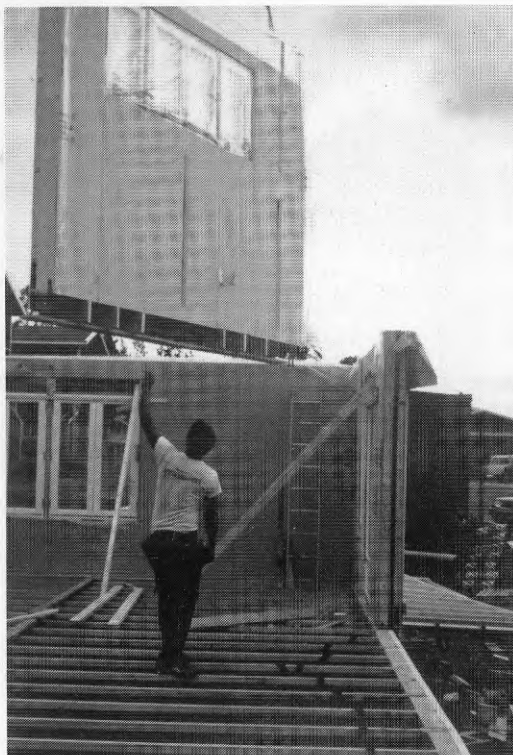
Ytterväggslementen lyfts på plats.
