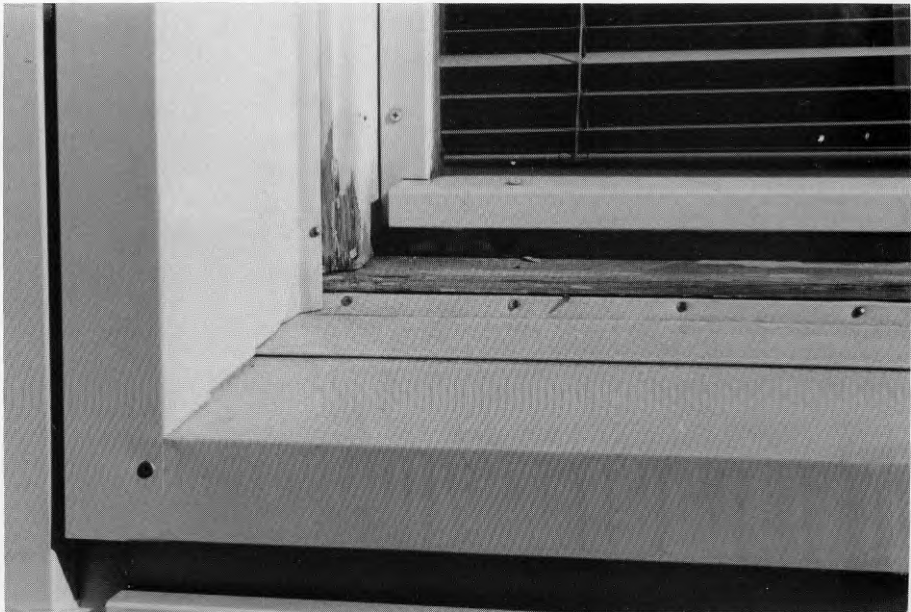
Fig B4:4 När profilerna monterats bort uppmättes fuktkvoter mellan 6,8 och 10% och förutsättningarna var lika föregående. Det visade sig att de behandlingar som gjorts före uppsättningen av beklädnaden var bortskrapning av löst sittande färg och inoljning. Någon förändring av ytskiktet kunde ej märkas.
