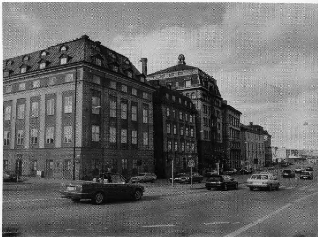
Byggnad som lutar till följd av ojämna sättningar.
