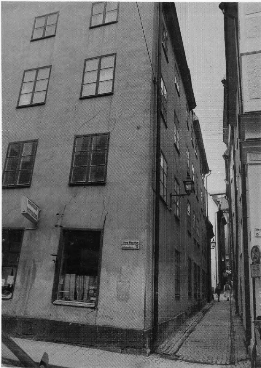
Vy från Gamla Stan med sättningskadat hus.
