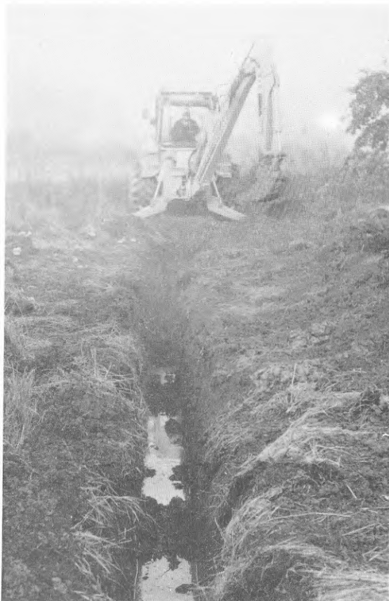
Figur 4.5. Traktorgravare längs installationsdike.
