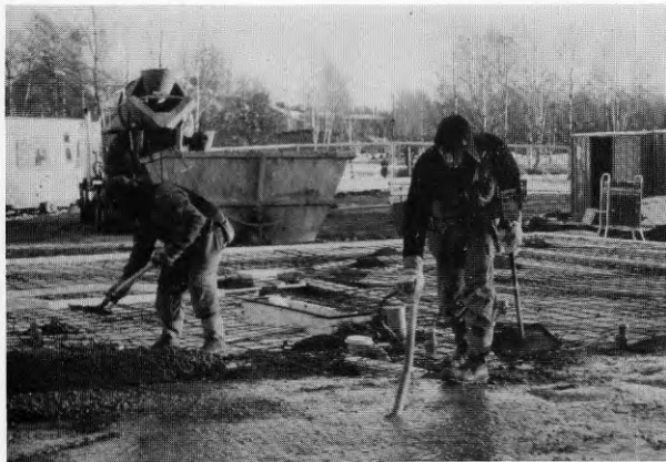
FIG 14-16 Grundplatta med "Legalettsystemet"
