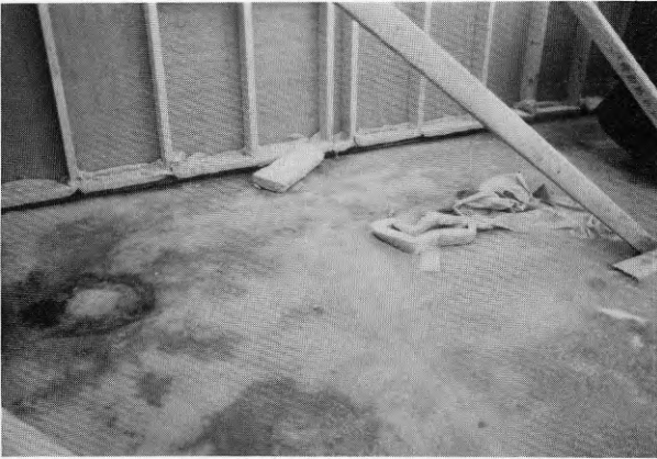
FIG 34. Syllen skyddad från nederbörd med mineralull
