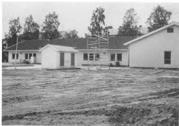
FIG 28 Utvändig målning Kompletteringsarbeten
