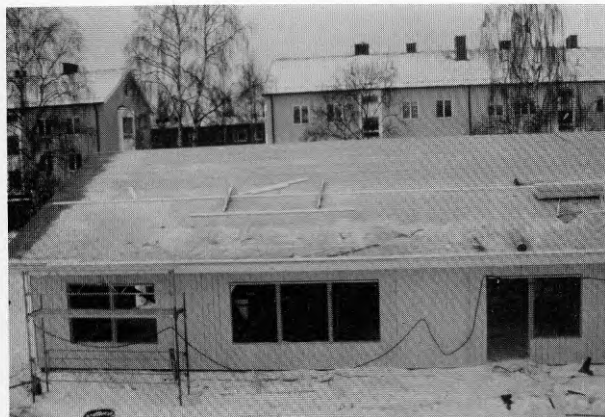
FIG 20-22 Stommontering fort- sätter. Isolering av väggar och tak. Fönster monteras Golvvärmen startas
