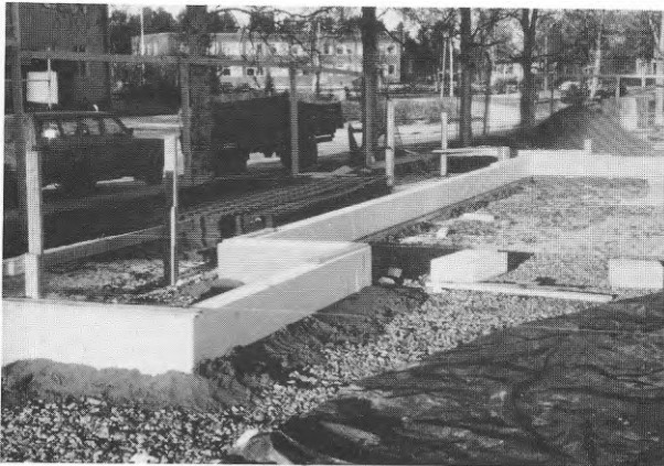
FIG 11-13 Byggstart, markarbeten, grusbädd till grund- platta
