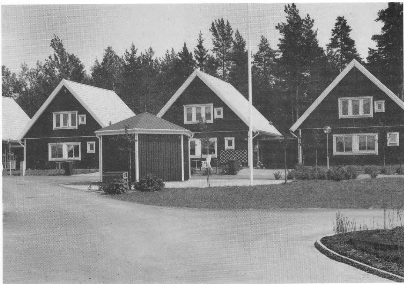
I kvarterets mitt finns en liten platsbildning med flaggstång - och undercentral.
