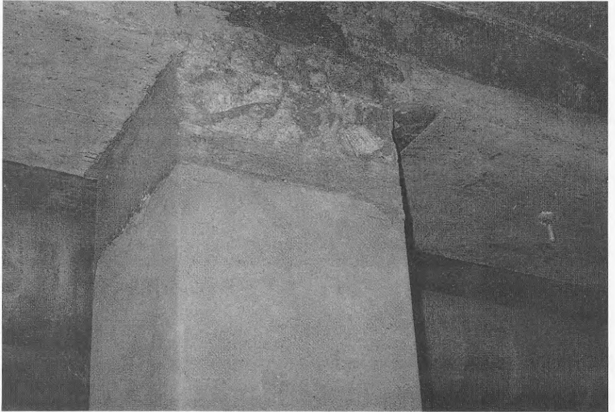
Figur 5.10 Reparation enligt 5.3.6. Anslutning till balk vid tak. Undergjutning med expanderande undergjutningsbetong.
