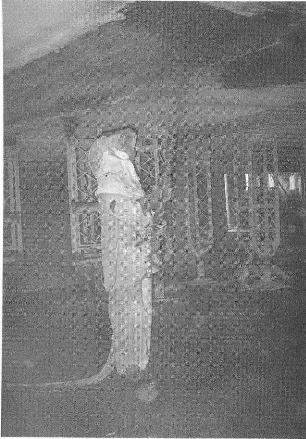
Figur 3.6 Applicering av sprutbetong
