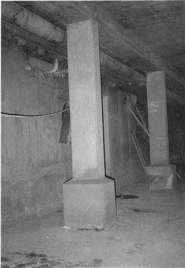
Figur 5.1 Reparation av pelare enligt 5.3.1.
