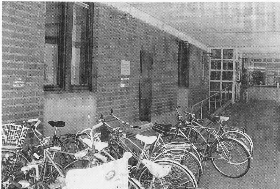
Bild 70 Vid Skatteförvaltningen i Gävle finns de ideala cykelparkeringsplatserna – nära och under tak – om än inte alldeles legala.
