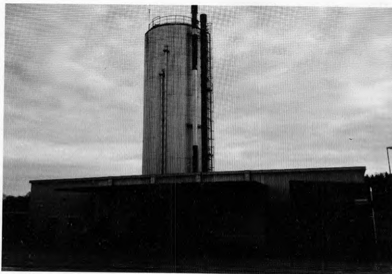
Figur 3.2 Fjärrvärmecentralen med värmeackumulatören i bakgrunden.
