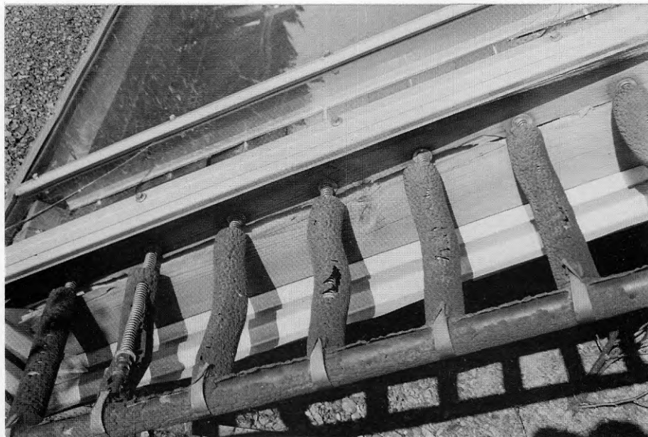
Fotografi 28 Tumba. Armaflexisolering som exponerats för väder och vind några år.
