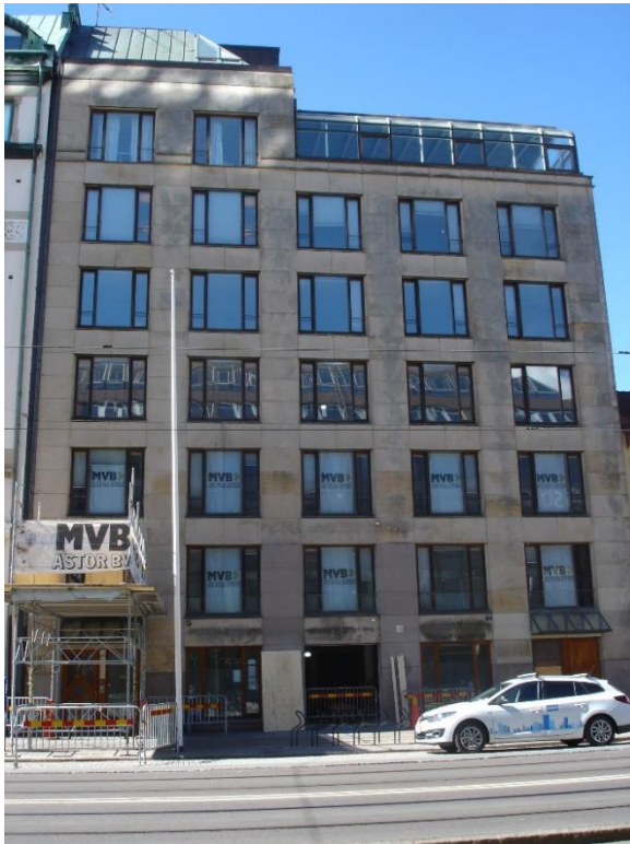
Fig. 10 Bankhusets fasad mot Östra Hamngatan. Foto: Emma Karp.
