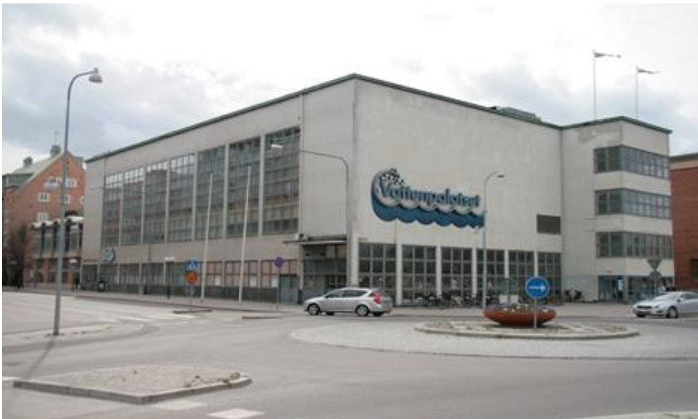
Fig. 13 Badhuset från 1930-talet och det tillbyggda äventyrsbadet från 1985 till vänster i bilden. Foto: Emma Karp.
