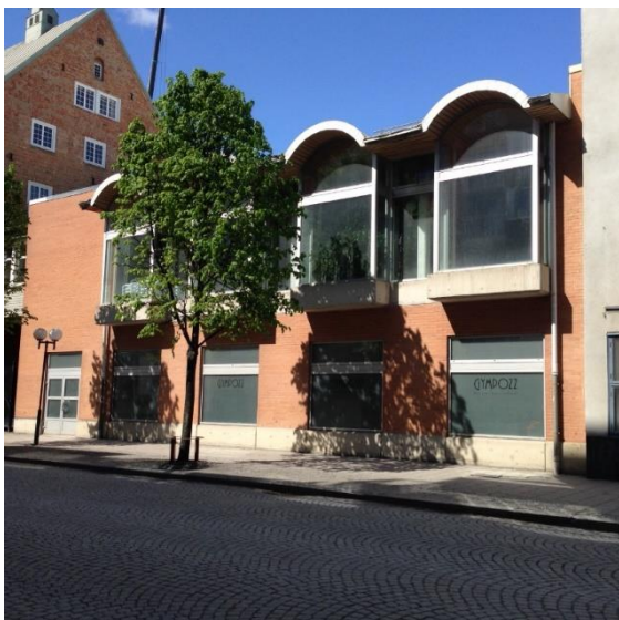
Fig. 14 Äventyrsbadet, 1985, fasad mot Drottningg. Foto: Ingela Karp.
