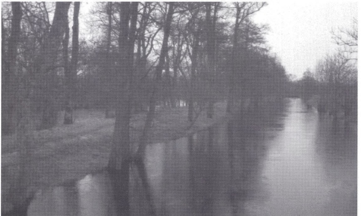
Intagskanalen till minikraftverket i Veddige. Viskan till vänster.
