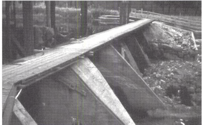
Linebergs kraftverksdamm med fisktrappa (i bakgrunden).
