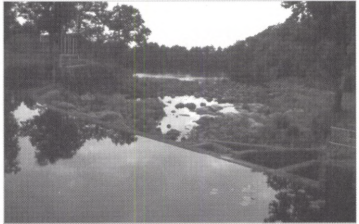
Vy över Nissan nedströms vid Sperlingsholm. Fisktrappan skymtar till höger i bild.
