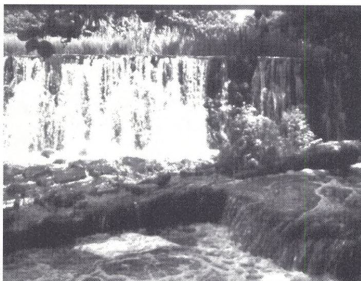
Dämme och fisktrappa i Rössjöholmsån vid Munka-Ljungby.
