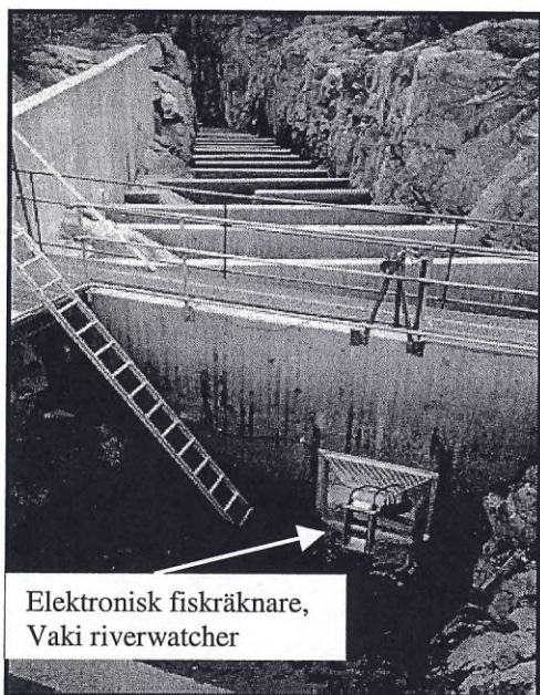
Foto 5. Elektronisk fiskräknare, Vaki Riverwatcher, installerad 1998 i Jockfall, Kalixälven. Foto: Benedikt Hålfdanarsson.
