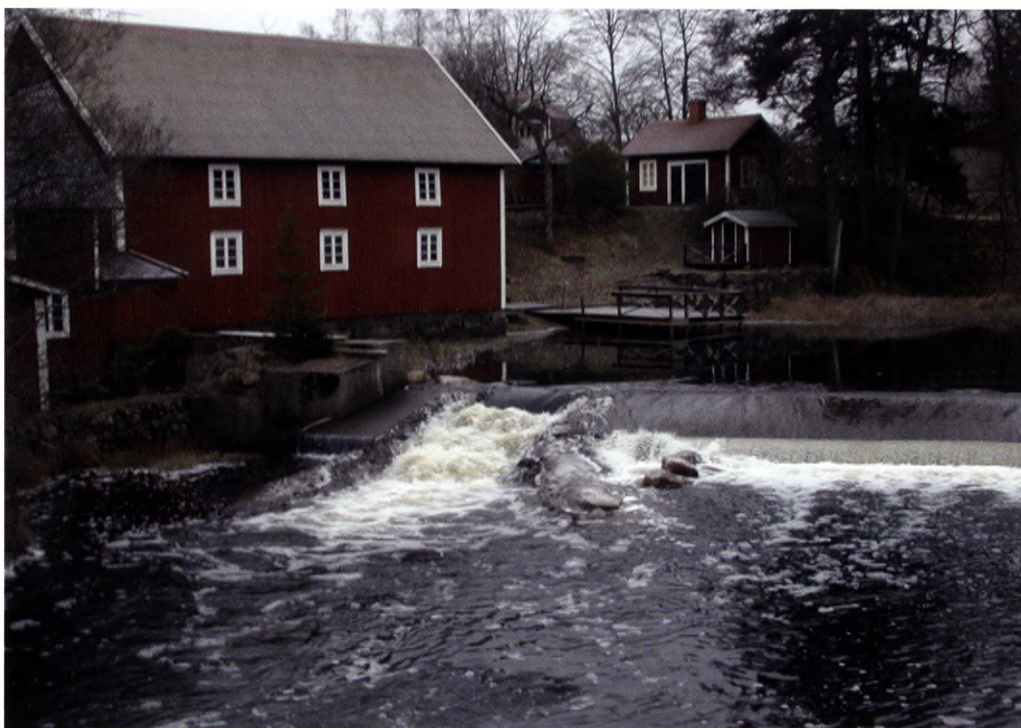
Fig. 2.1 Fisktrappa i Skibord, Alsterfors, Kalmar län. Fisken kan fortsätta sin vandring uppströms genom trappan som har byggts in i skiborden. Ingreppet har inte ändrat karaktären på miljön i stort. Foto: Erika Grann, Riksantikvarieämbetet.
