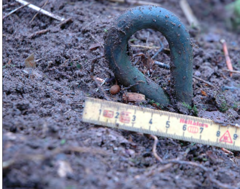
Ovan: Förankringsögla för stagvajer till telestolpe. Foto: Frida Hauge Andersson
