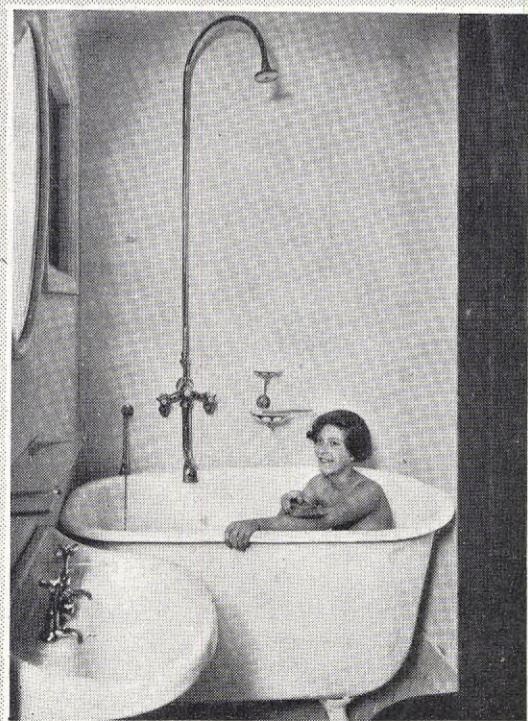
Bygge och Bos enrumslägenhet av arkitekt A. Stark är värd all uppmärksamhet för sin utmärkta planläggning och utnyttjande av det lilla yttnehållet. I badrummet presenterar man ett litet sittbadkar — god idé.
