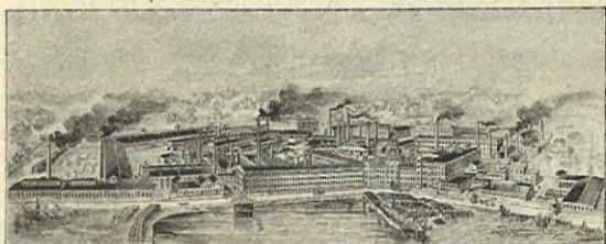
THE AMERICAN STEEL & WIRE CO: CENTRAL-VERKSTÄDERNA.
