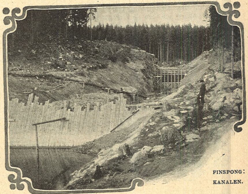
FINSPONG: GENOMSPRÄNGNING FÖR KANALEN.
