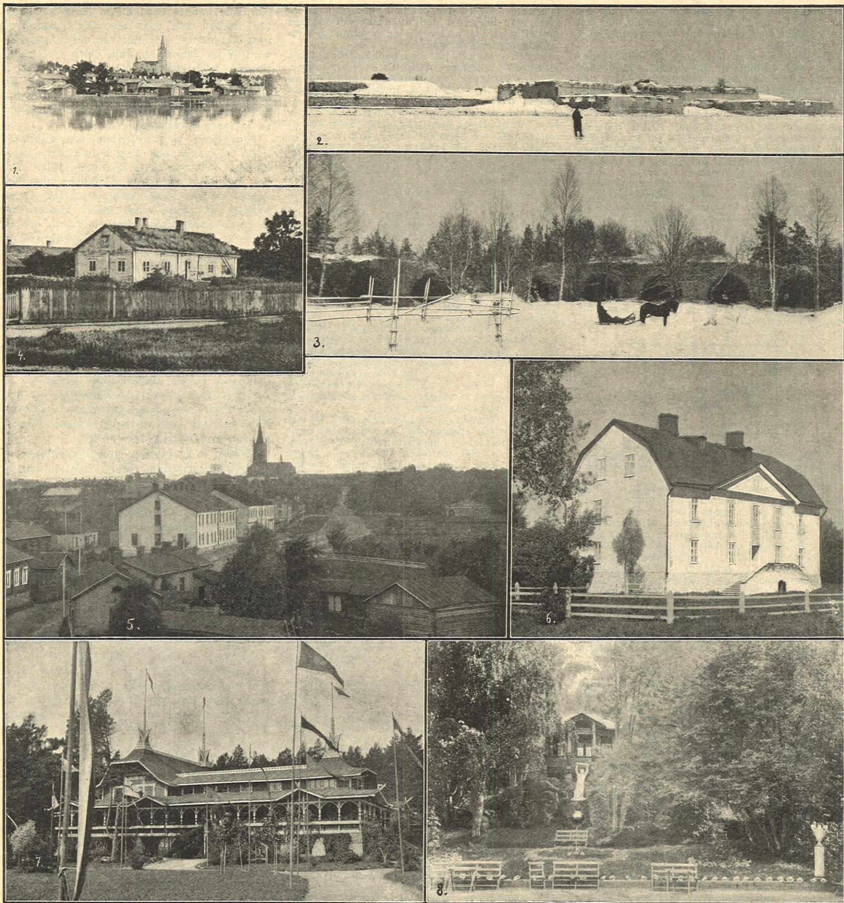
BILDER FRÅN LOVISA. 1. UTSIKT AF LOVISA FRÅN SJÖSIDAN. 2. SVARTHOLMS FÄSTNING VID INLOPPET TILL LOVISAVIKEN. 3. FÄSTNINGSRUINERNA I LOVISA. 4. DEGERBY RUSTHÅLLS KARAKTÄRSBYGGNAD. 5. UTSIKT AF LOVISA MED KYRKAN, DE GAMLA SVENSKA SOLDATKASERNERNA OCH »ÖSTRA NYLANDS» TRYCKERI. 6. F. D. KOMMENDANTSBOSTÄLLET. 7. CASINO. 8. MUSIKPAVILJONGEN.
