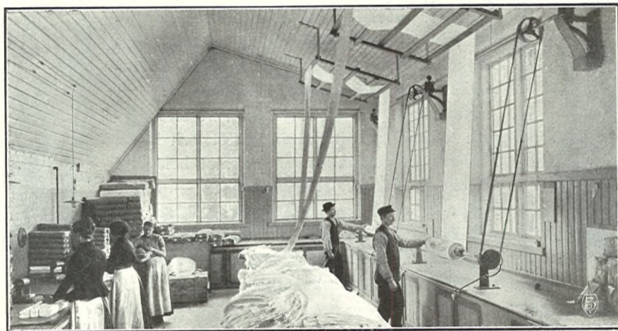
Gamlestadens Fabriker — Granskningsrummet.
