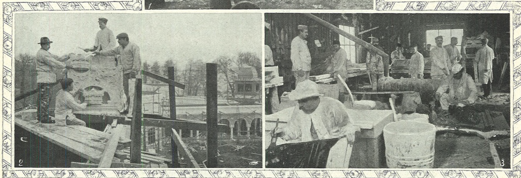
1 FRUKOSTRAST UTANFÖR HUFVUDINGÅNGEN. 2. ORNAMENTSARBETE PÅ MURTINNARNE. 3. I GIPSGJUTAREVERKSTADEN. A. BLOMBERG FOTO.
