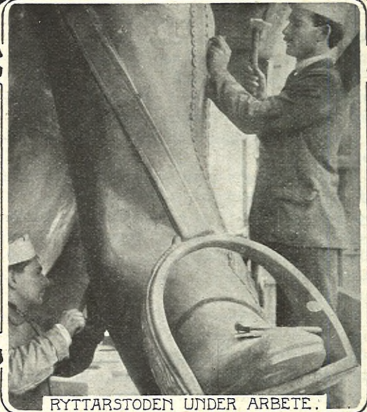
RYTTARSTODEN UNDER ARBETE.
