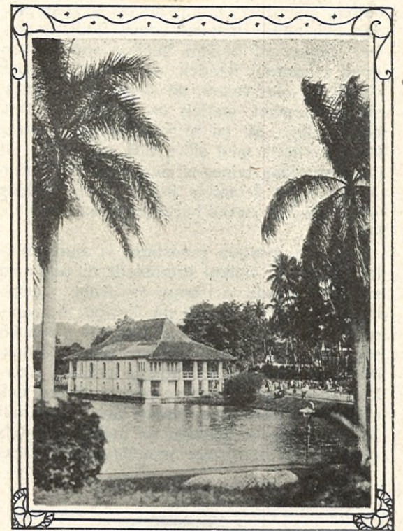
Kandysjön med biblioteksbyggnaden.
