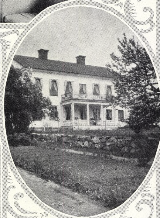
Främsbacka corps de logi från sjösidan.
