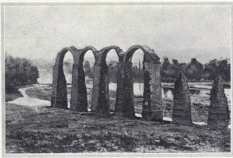
Vad som finns kvar av romarnas vattenledning över floden Bormida i Acqui.
